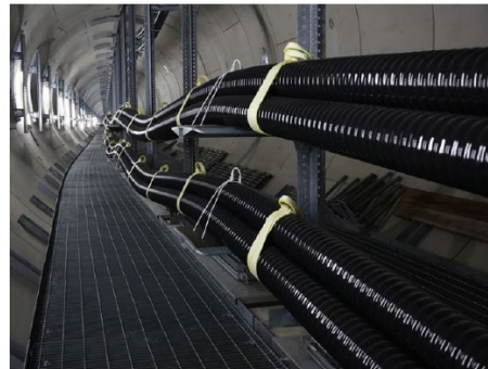
地下トンネル（洞道）内部
